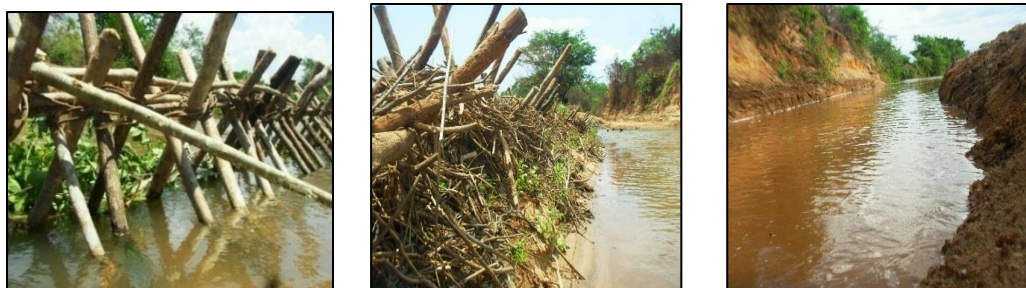
Figure 1 : Principe général du Système de Gravitation Hydro Agricole (SGHA) : (a) Dispositif installé ; (b) Résultat après inondation ; (c) Irrigation vers la plaine.
